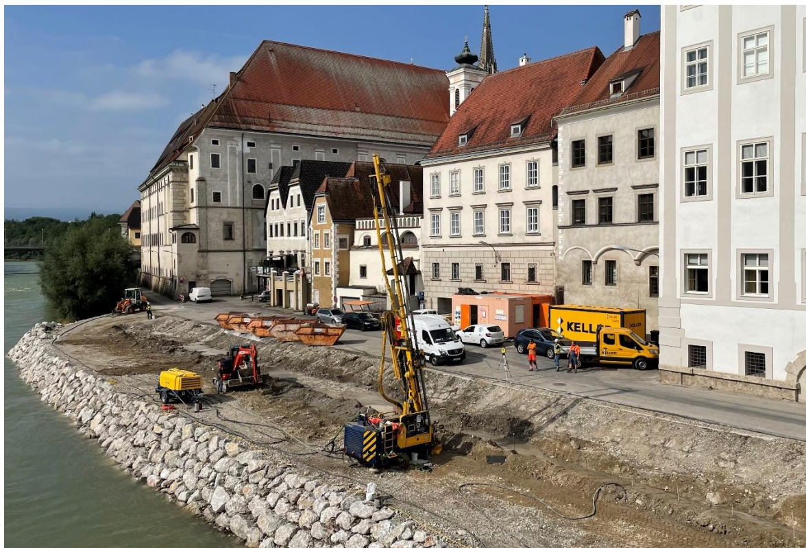
Abbildung 1: Baufeld Ennskai Steyr
