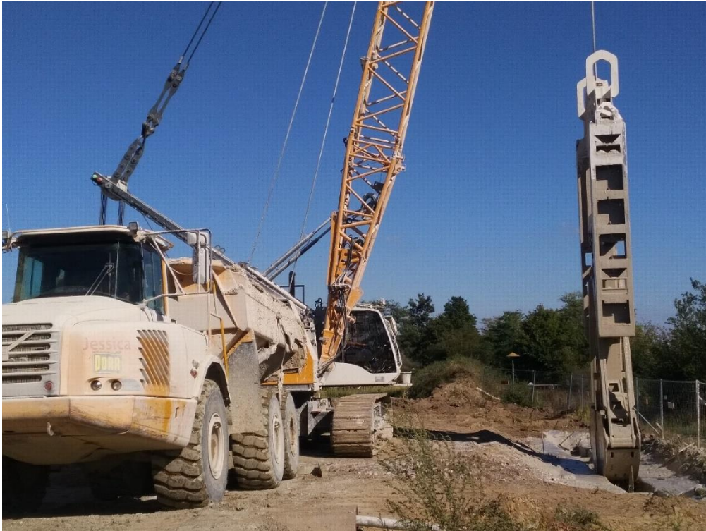
Abb. 1: Herstellung Schlitzwand (Quelle: Kommunalkredit Public Consulting GmbH)
