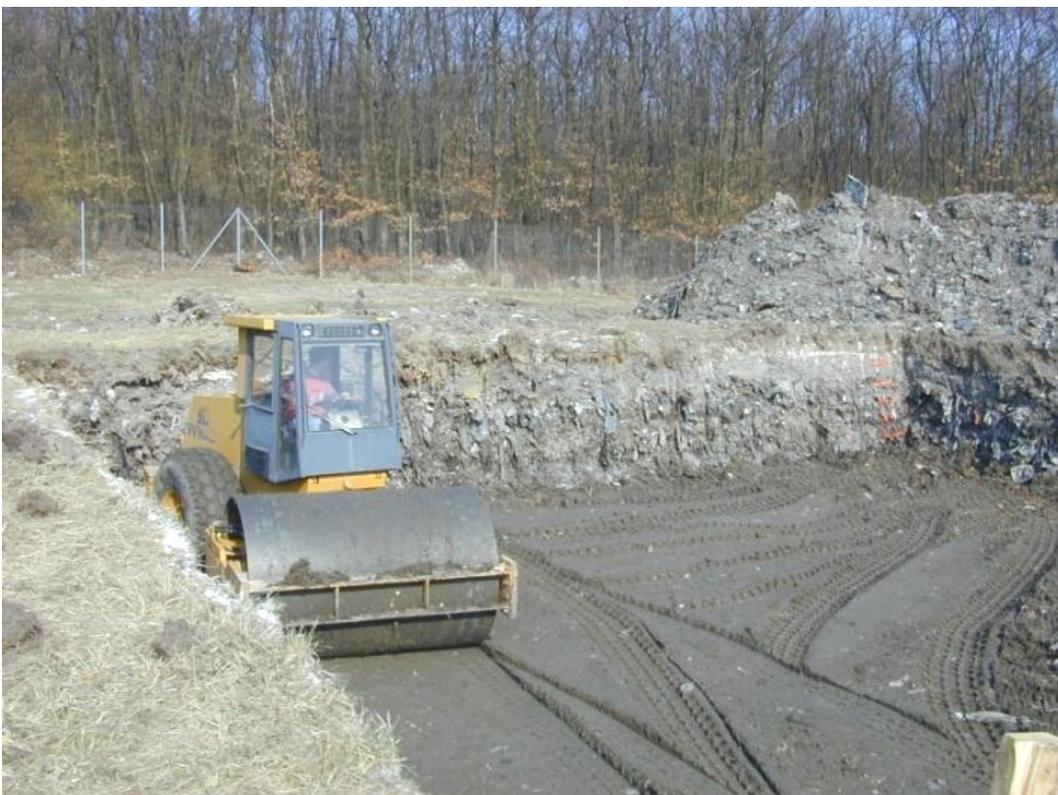
**Abbildung 2:** Einbau der immobilisierten Abfälle in ein Versuchsfeld auf einer Deponie
