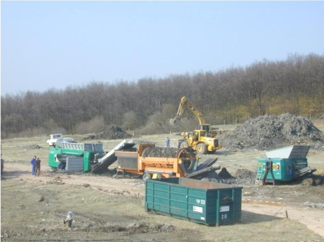
**Abbildung 1:** mobiler Immobilisierungszug bestehend aus Schredder, Trommelsieb und Mischanlage für die Immobilisierung; im Hintergrund unbehandelte Altabfälle;
