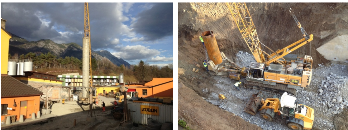
Abbildung 4: Großlochgreiferbohrungen
