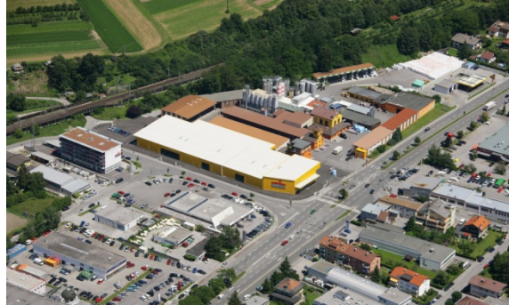
Abbildung 2: Luftbild des aktuellen Baubestandes
