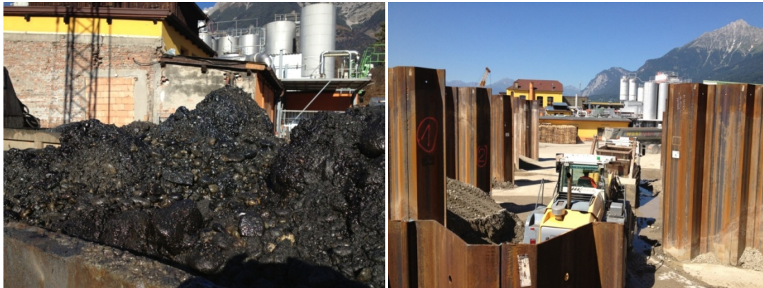
Abbildung 5: Teeröl kontaminiertes Aushubmaterial (links), Zwischenlager (rechts)
