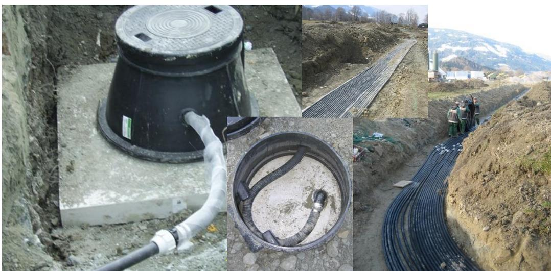
Abb. 4a-d: Belüftungsbrunnen, Leitungsverlegung
