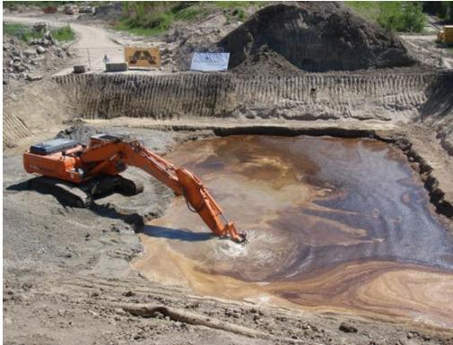
Abb.2: Aushub aus einem Hot-Spot
