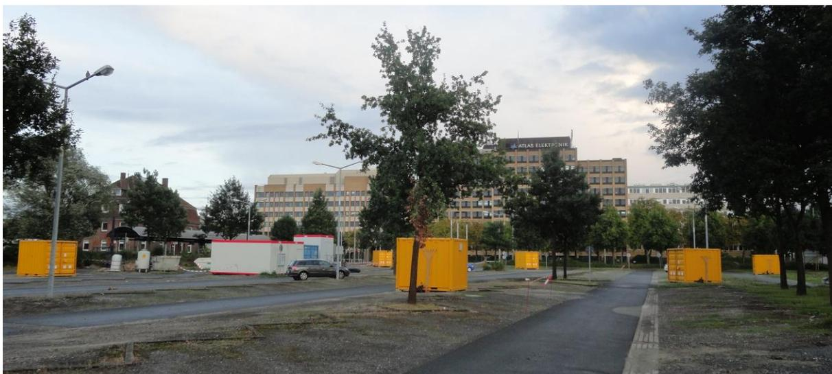
**Abb.5:** Die Gesamtsanierung des LCKW-Grundwasserschadens am Standort der ehemaligen Silberwarenfabrik erfolgt mit Hilfe von 10 GZS, die für eine Kombination des ISCO- und des ISBR-Verfahrens genutzt werden.
