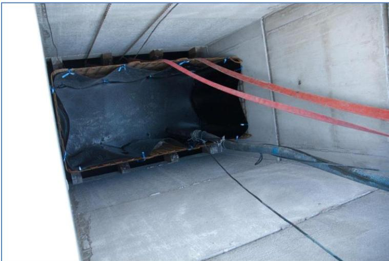
**Abb. 11: Detailansicht eines befüllten Filterelementes**
