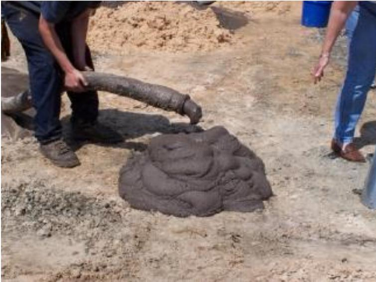
Abb. 4: Guarkernmehl-Sand-Eisen-Suspension
