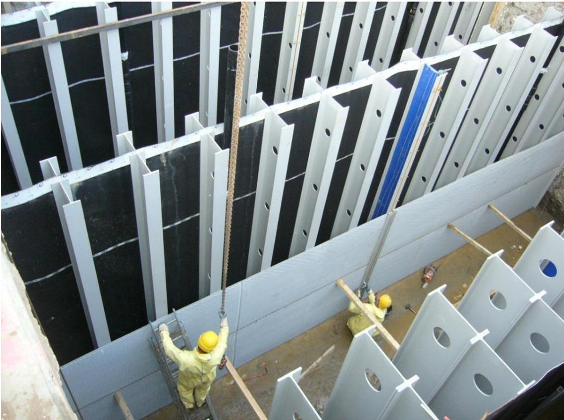
**Abb. 7: Montage der Schlitzbrückenfilterbleche**
