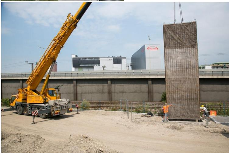
**Abbildung 5 - Aushubarbeiten im Bereich Gate 12 (linkes Bild) und Einbau Filterkorb in das Gate (rechtes Bild) [Quelle: Projektdokumentation]**
