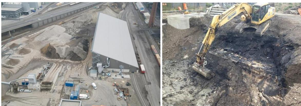
**Abbildung 7 - Lagerhalle mit davor liegendem Freilager und in Bau befindlicher Abluftreinigungsanlage (linkes Bild) und Kontamination der ungesättigten Bodenzone in einem Hot-Spot auf der STF2a (rechtes Bild) [Quelle: Projektdokumentation]**
