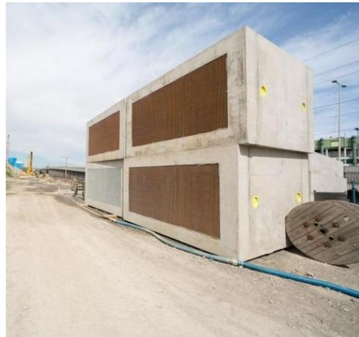
**Abbildung 4 - Maßnahmen zum ArbeitnehmerInnenschutz während der Errichtungsphase der Gates (linkes Bild) u. durchströmbare Betonfertigteile der Gates (rechtes Bild) [Quelle: Projektdokumentation]**
