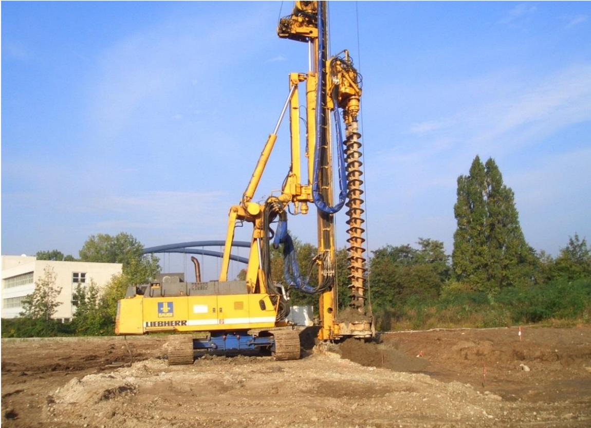
**Abb. 6: Herstellung der Leitwände in MiP-Bauweise**
