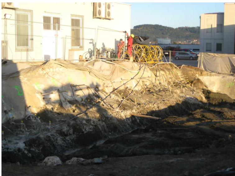
**Abb.3: Abgeteufte Manschettenrohrfächer am Standort O69 Deponie Freistadt**
