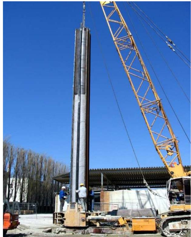
Abbildung 6: Einbau Filterrohr
