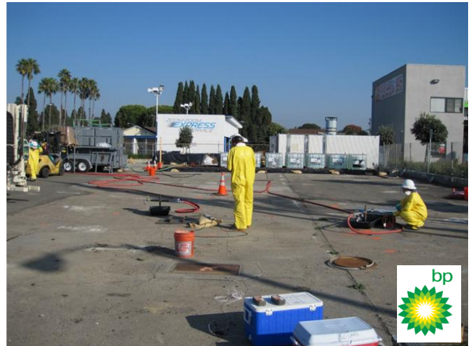
Abbildung 1: ISCO Bodensanierung mit NaOH (> pH10) aktiviertem Na-Persulfate – BP Huntington Beach
