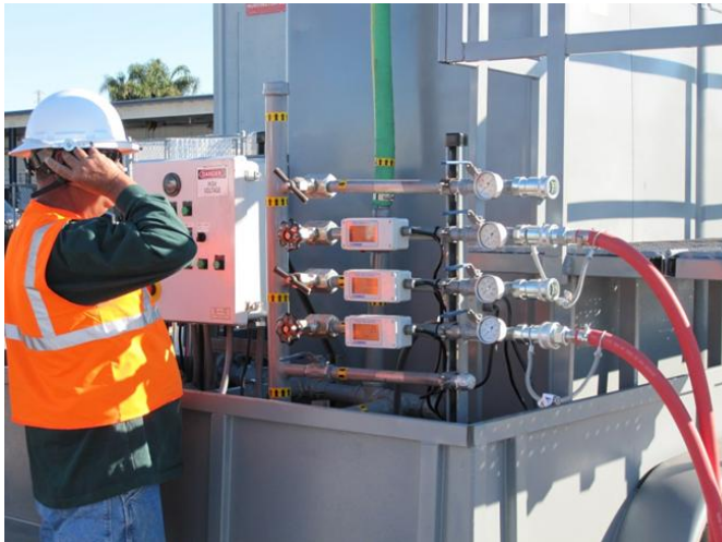
Abbildung 1: ISCO Bodensanierung mit NaOH (> pH10) aktiviertem Na-Persulfate – BP Huntington Beach
