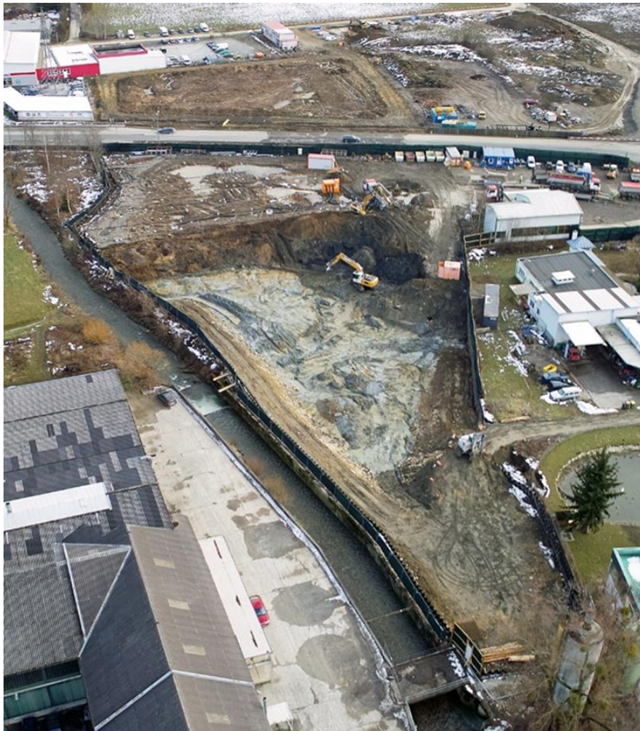
Abbildung 4: Räumung Nordbereich (Blickrichtung Süd), im Hintergrund Südostbereich mit B72-Querung
