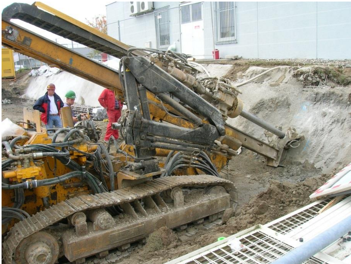
Abbildung 2: Injektion unter die bestehende Bebauung
