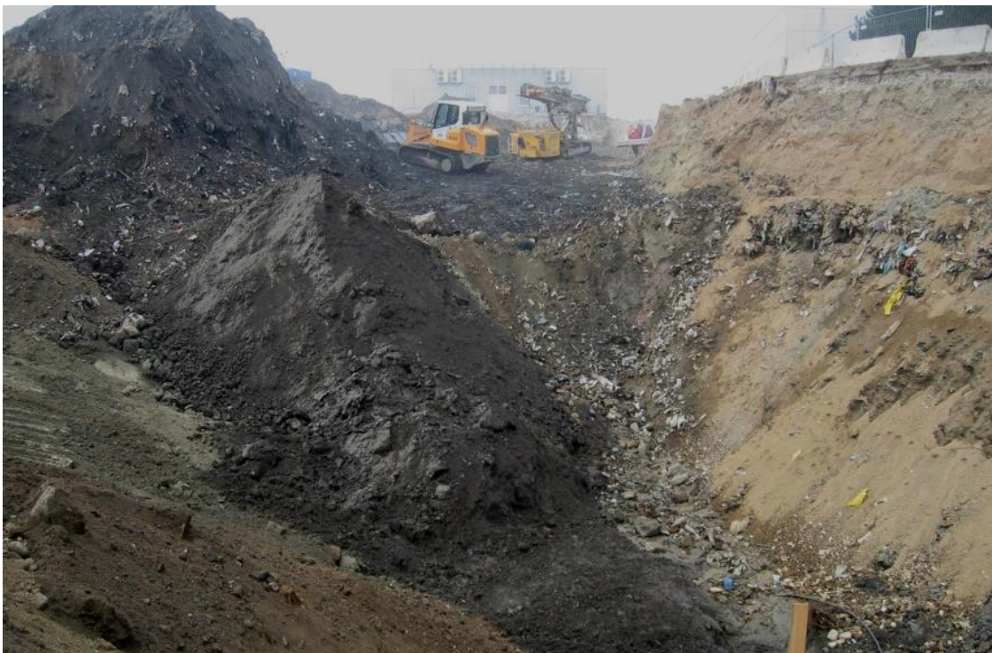
Abbildung 1: Räumung des kontaminierten Materials
