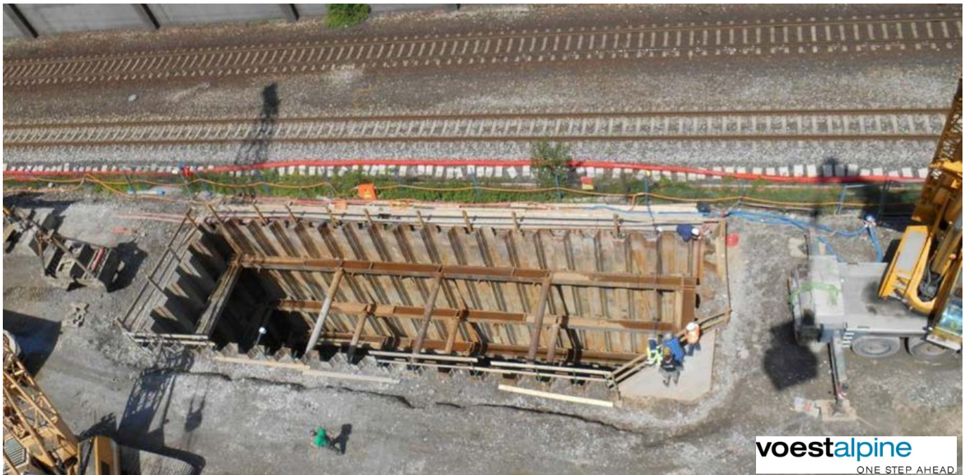
Abbildung1: Herstellung eines Gates – Fallstudie Sicherung der Kokerei Linz
